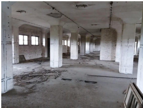
Fot.2. Wnętrze elewatorów w Świdnicy, materiały właściciela budynków.
