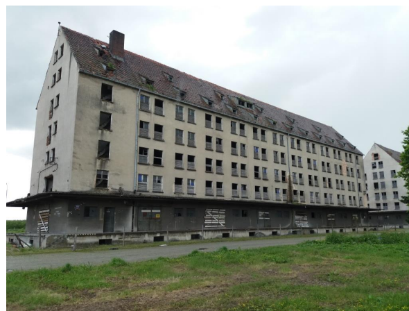
Fot.1. Elewatory w Świdnicy, materiały właściciela budynków.
