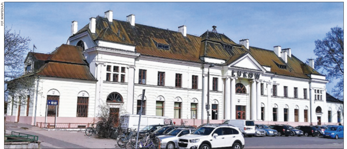
Łukowscy radni dali zielone światło do podpisania umowy z PKP i zainwestowania tym samym przez kolejową spółkę 20 mln zł w remont dworca.
