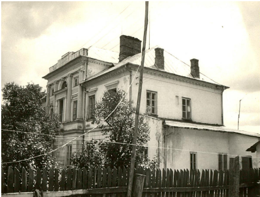
Fot. 8. Pałac w Sobieszynie – stan z 1988 r.; elewacja boczna – zachodnia. Źródło: Biała Karta, B. Skibińska, 1988
