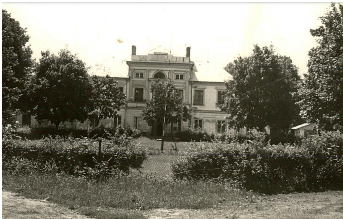
Fot. 5. Pałac w Sobieszynie – stan z 1988 r.; elewacja frontowa, na zdjęciu widoczna elewacja frontowa i gazon. Źródło: Biała Karta, B. Skibińska, 1988
